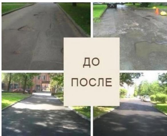
Выполнен ремонт асфальтового покрытия внутридворовой территории по адресу Б. Сампсониевский пр., д. 79. Общий объем работ составил 1857 кв. м.
